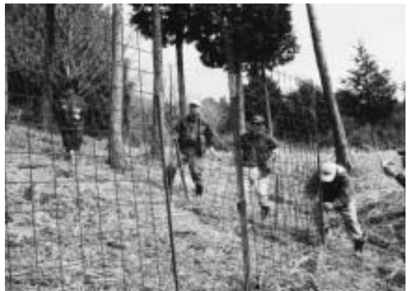
防護柵の設置作業
