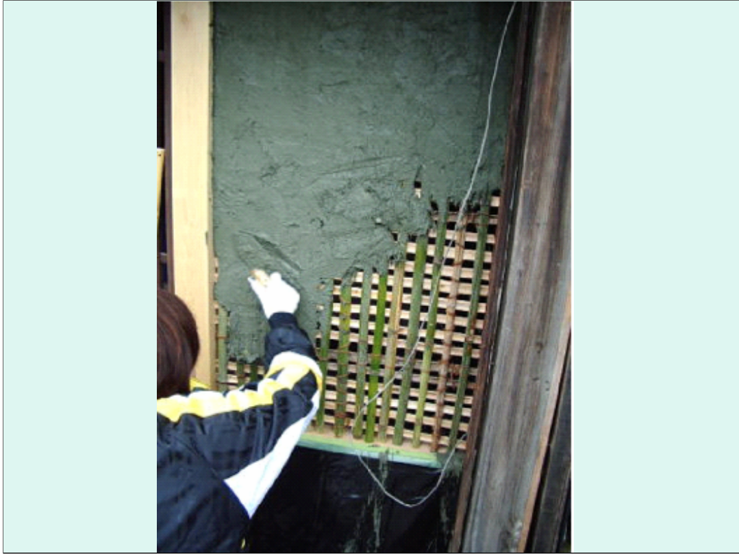
古民家を改修する様子
