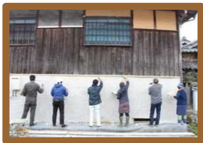
大人も夢中になる土壁塗りの作業
